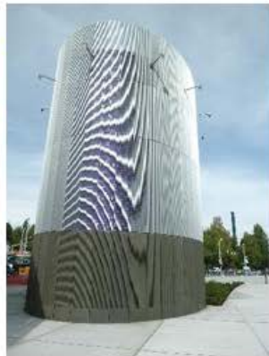
位于西雅图UW车站的垂直通风口 Vertical ventilation at UW Station in Seattle
